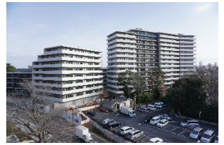
C 街区工事状況 (1月19日撮影)
