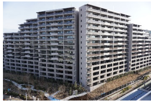
A 街区工事状況 (1月19日撮影)
